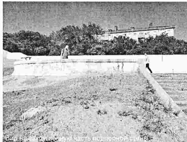
Вид на загруженную часть подпорной стены
