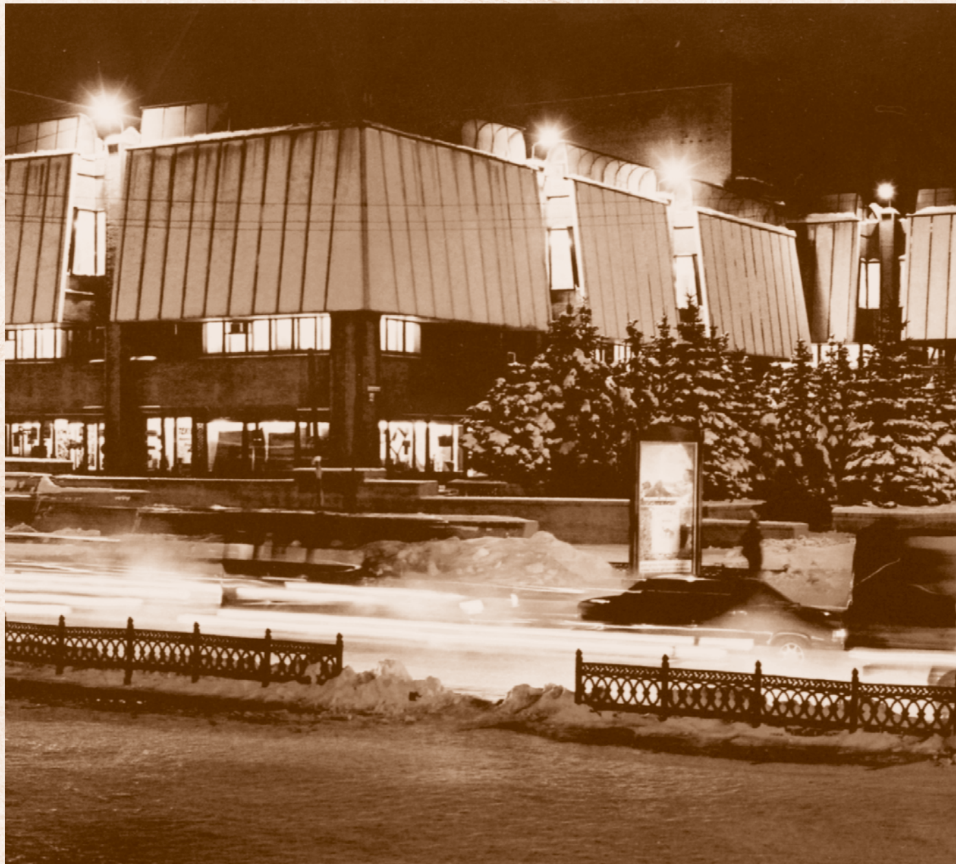
Торговый центр «Омский» 24 . 2002
