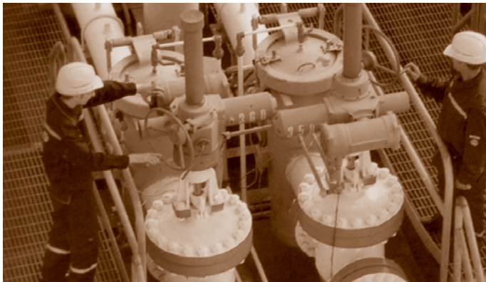
Системы измерений количества и показателей качества нефти на линейной производственно-диспетчерской станции.
