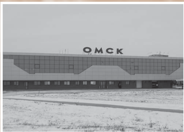
Здание омского аэровокзала
