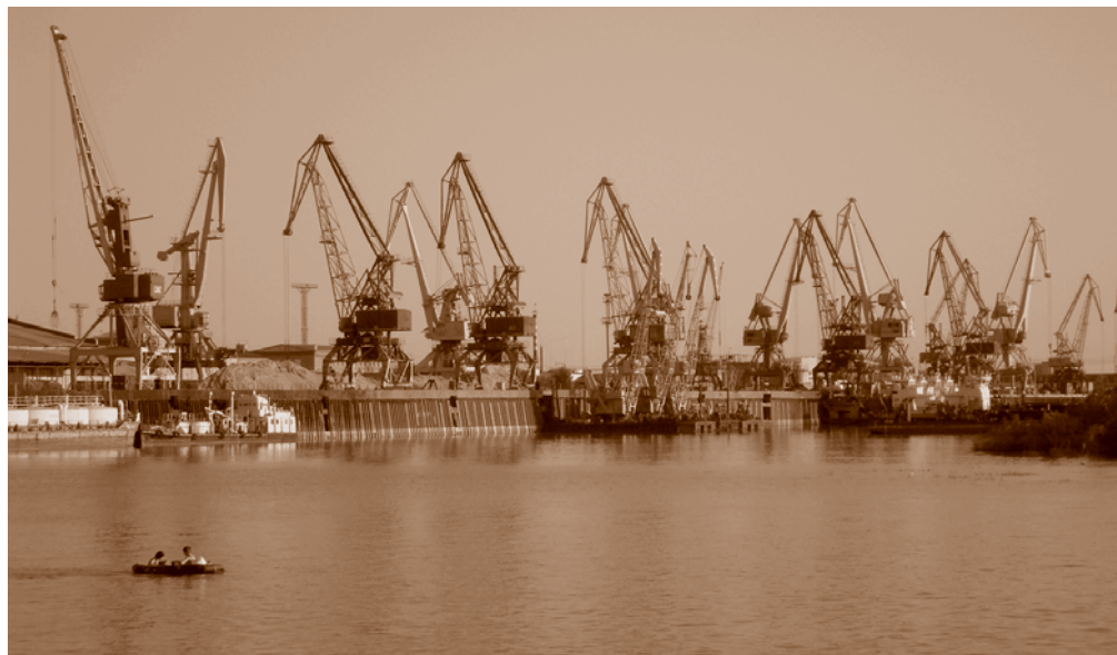
Причальная стенка правобережного комплекса Омского речного порта. Фотография В. Н. Ляпина 2008 г.
